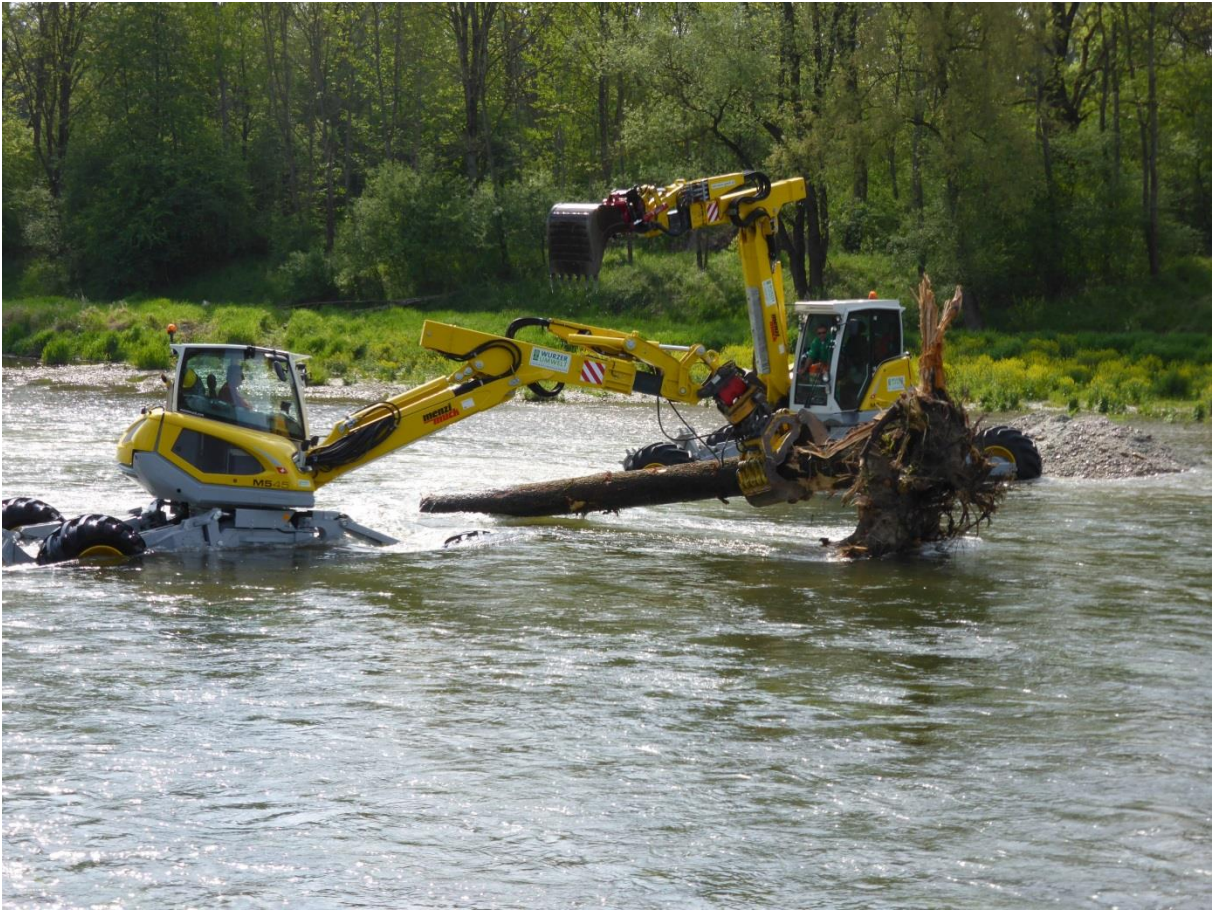
Bild: Einbau von Totholz in die Isar bei Flusskilometer 86,6
