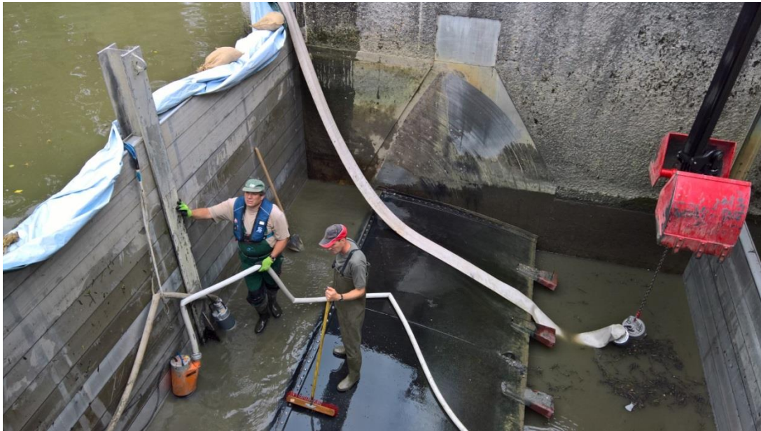
Abbildung 1 Die Vils ist mit Dammbalken oberstrom und unterstrom des Wehres abgesperrt
