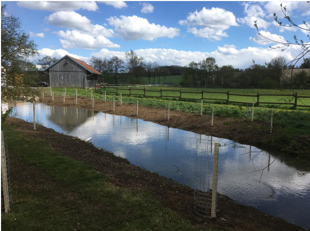
Foto 2: Uferabflachung und -bepflanzung mit Blick entgegen der Fließrichtung (Adolf Hörl/ Flussmeisterstelle Landshut)
