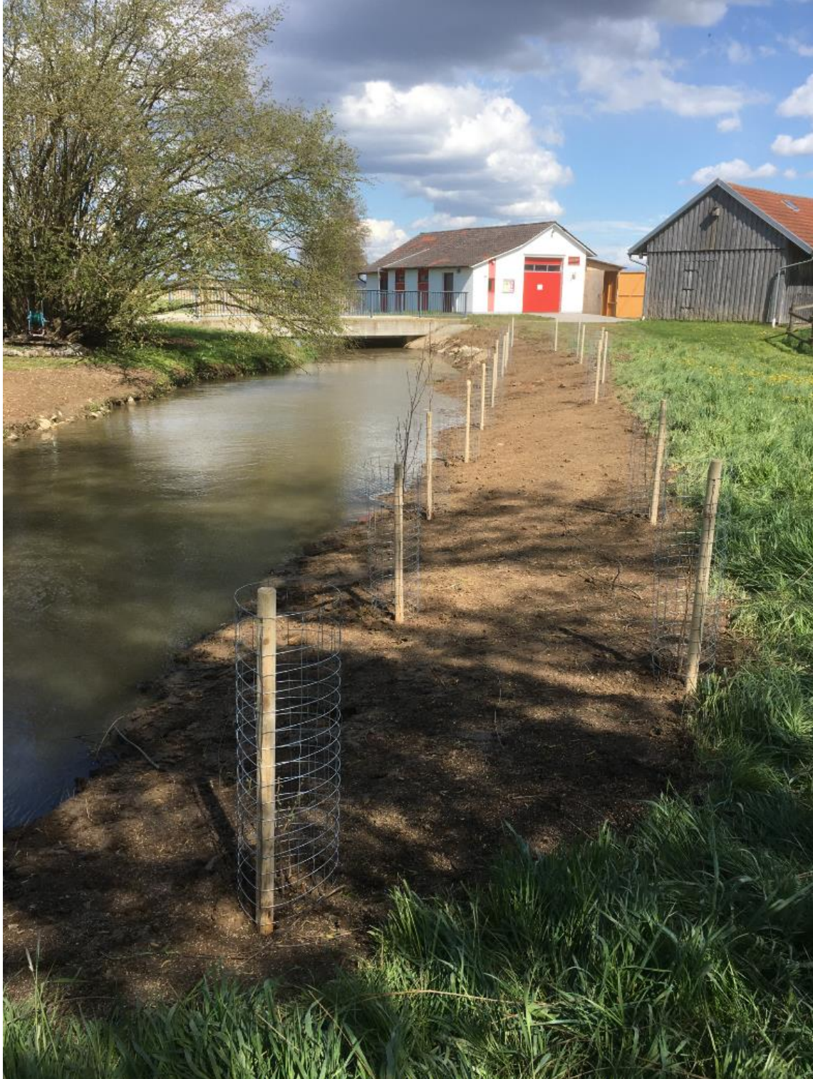
Foto 1: Uferabflachung und -bepflanzung mit Blick in Fließrichtung (Adolf Hörl/ Flussmeisterstelle Landshut)
