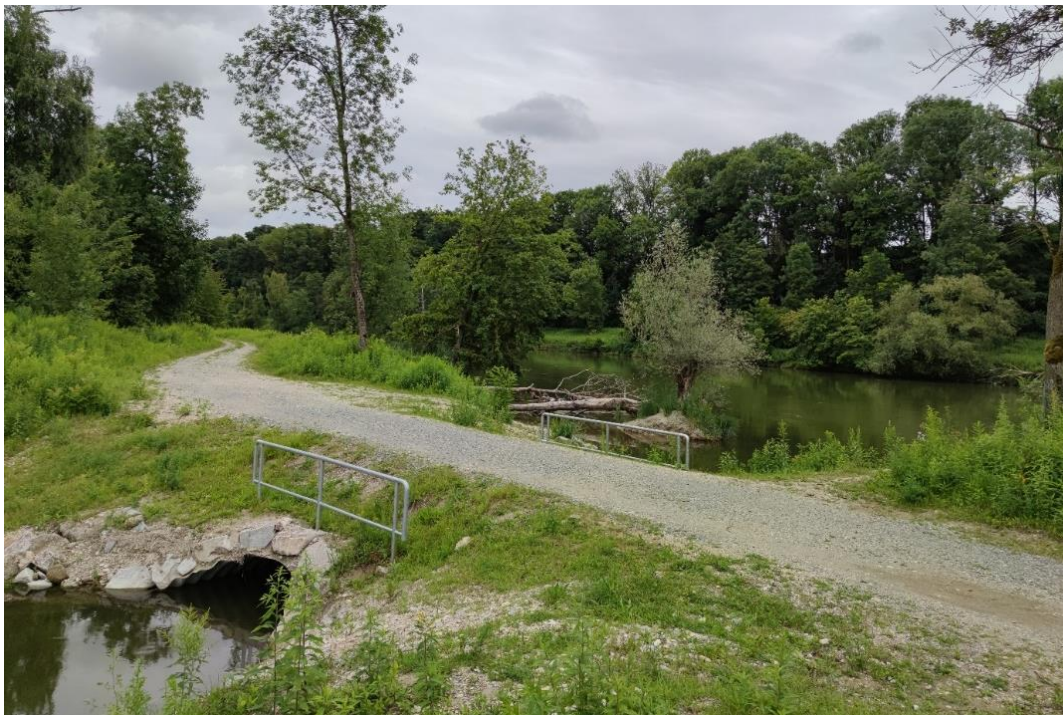
Abbildung 2 - Neue Rohrverbindung mit vergrößertem Querschnitt und Kies- und Totholzeinbauten in die Isar
