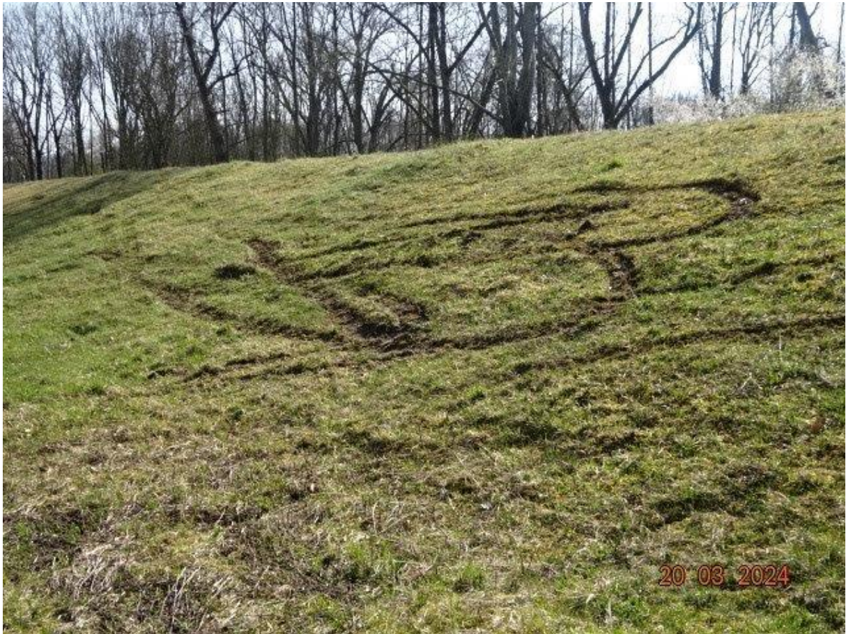
Isardeich im Bereich Landau (Bildautor: Ewald Ammer, WWA LA)
