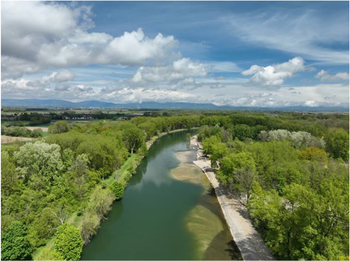
Abbildung 2: Aktueller Zwischenstand Mai 2024 nach Kieseinbringung (Foto WWA)
